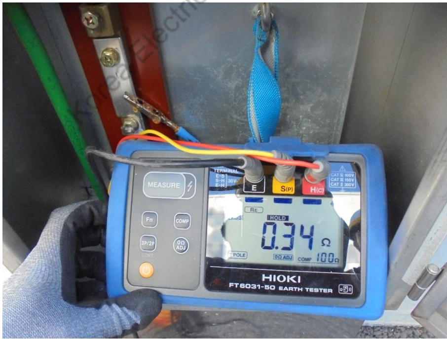
옥외 95% 에탄올 피뢰접지
