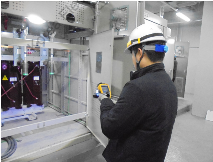
적외선 열화상 측정
