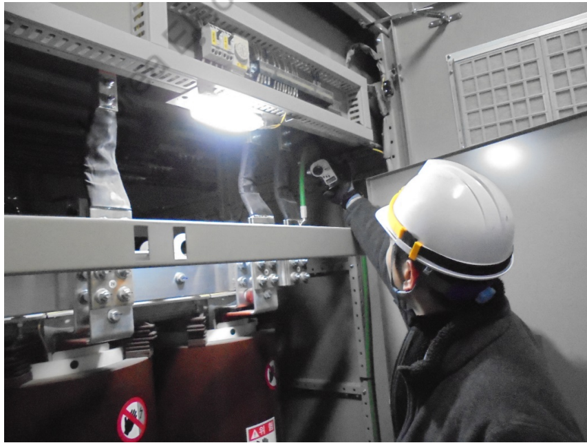
변압기 2중접지선 누설전류 측정
